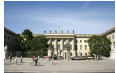
Fig. 1: Main building of Humboldt-Universität zu Berlin, Unter den Linden
